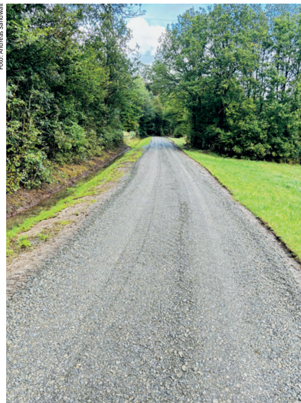
Der neu befestigte Schotterweg zeigt das Ergebnis des Waldwegebaus.
