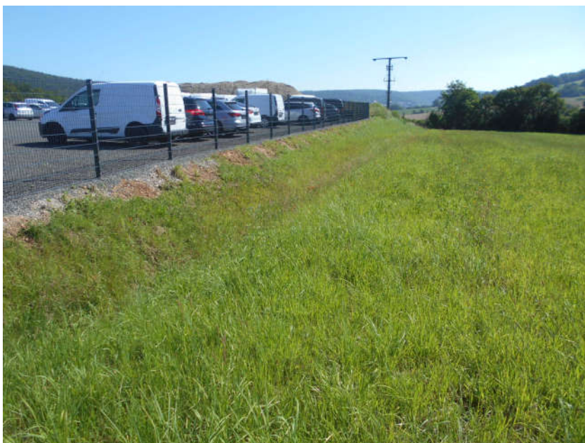
Blick entlang der Böschung am Nordrand der Fl.Nr. 975 mit Blickrichtung nach Osten (Foto S. Mayer, 08.06.2024)
